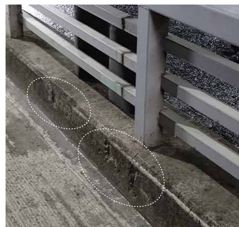
鉄筋露出コンクリート断面欠損
