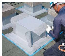
下塗り～メッシュJK施工
