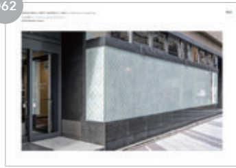
日本橋ライフサイエンスビルディング7 エントランス
