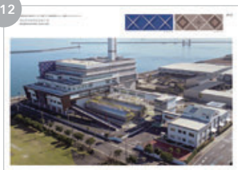
鹿児島市新南部清掃工場 焼却プラント壁
