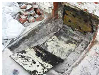
防水層切取り
