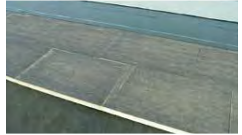
ギルフォーム施工例
