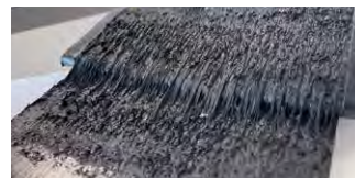
ガムロン粘着層 (施工直後の引き剥がし実験)
