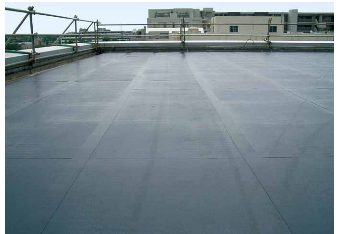
バリボードPS敷設
