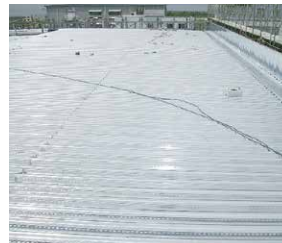
ルーフデッキ設置
