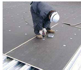
MHワッシャー留め付け
