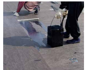
断熱材2層目貼り付け
