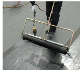
強力ガムフェース施工
