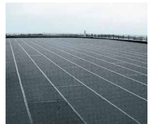
強力ガムフェース施工完了
