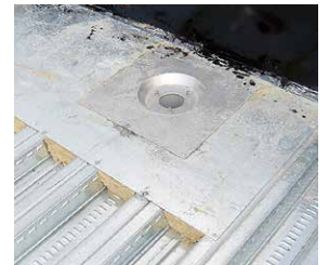
HTドレンたて設置
