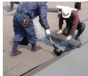
強力ハイキャップ施工
