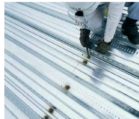
ルーフデッキ設置
