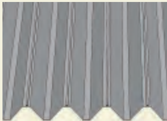
既存折板下地
