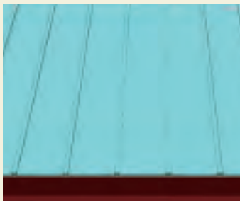
既存瓦棒下地
