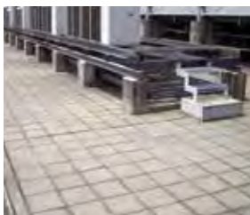
既存タイル下地
