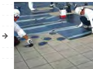
バリボードPS(アスファルトパネル)貼り
