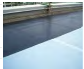
オルタックシート貼り
