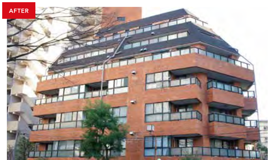
実際にシングルにて改修工事を施工した建物(SA-310)
