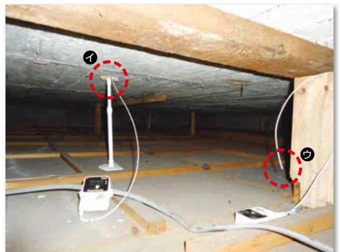
屋内：コンクリート下面、小屋裏温度測定用
