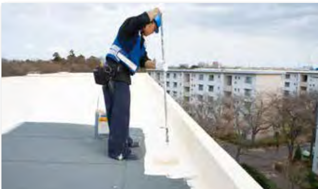
■高反射塗料「SPサーモコート」塗布／完成
