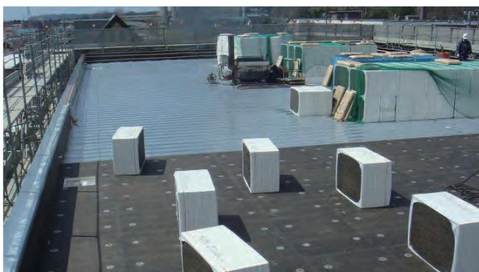
1. 耐風圧性確保のため、薄いデッキプレート上への固定力を十分考慮した専用ビスや接着剤。
