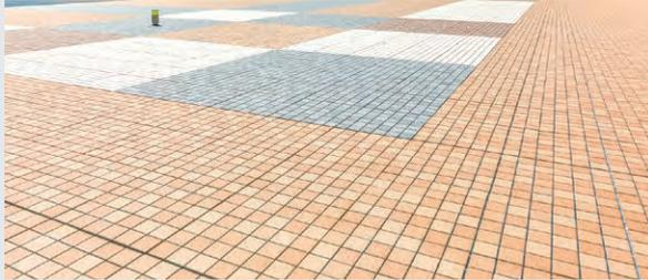
耐久性の高い磁器タイル小片を連結した保護仕上げ材です。裏面に粘着層が設けてあり、下地に貼付けるだけの簡単施工です。小片はあらかじめ同色系を組合わせてあり、敷設するだけで屋上やベランダに高級タイル調の美しい世界が広がります。
