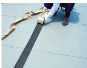
下地と断熱を兼用する屋根30分耐火認定を取得したYPパネルを用いた構法です。屋根の大幅な薄層・軽量化が可能です。
