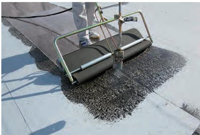
1. 溶融釜を用いずに、熱工法と同等の水密性を得られます。
