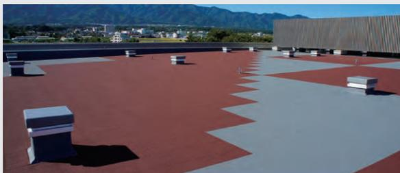
表面に焼成彩色砂や自然色砂を隙間なく圧着させた厚さ6mmのアスファルト系砂付成型板です。2色または3色を組合わせてカラフルで美しいパターンの屋上が仕上げられます。熱工法向けの「バリキャップ」と冷工法向けの「バリキャップP(粘着層はついていません)」があります。
