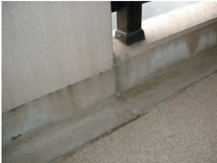
微細な亀裂や目地から雨水が徐々にコンクリート中に浸透していきます。
