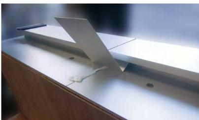
キャントをFEC25用ビスにて固定後、下部ジョイントにキャント用ジョイント板をシール材で貼付け。
