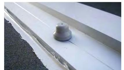
ビス頭部分にシールを打った後、Pキャップを被せる。
