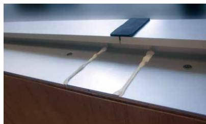
貼付け後、ジョイント板両脇にシール打設。上部ジョイントに板パッキンを貼付け。
