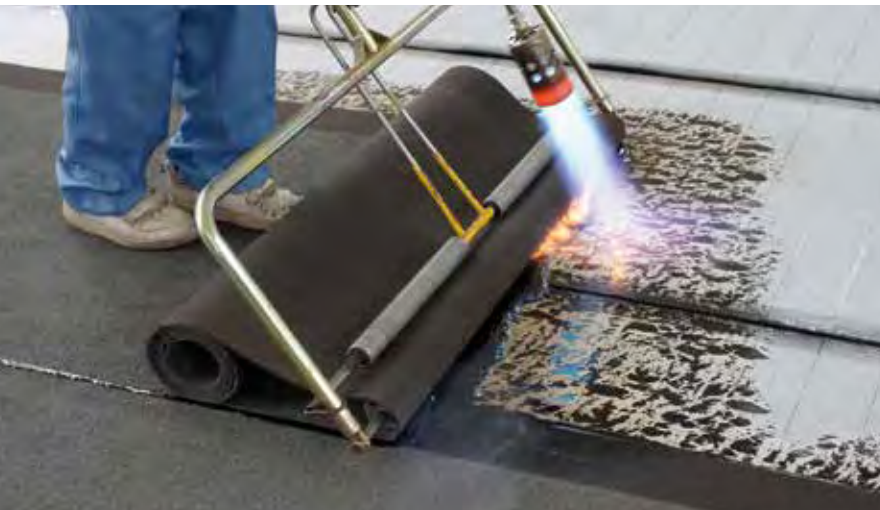
下層ルーフィングの表面をバーナーで炙ることで、表層の易溶融性アスファルトが溶け出し、アスファルトの溜り(バンク)を作り、その上をルーフィングを転がしながら貼付け・積層する。
