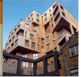
CLTと鉄骨による混構造10階建て集合住宅(ロンドン)。写真提供/日本CLT協会
