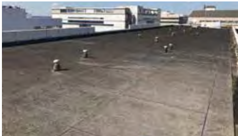
防水層保護コンクリート(既存)
