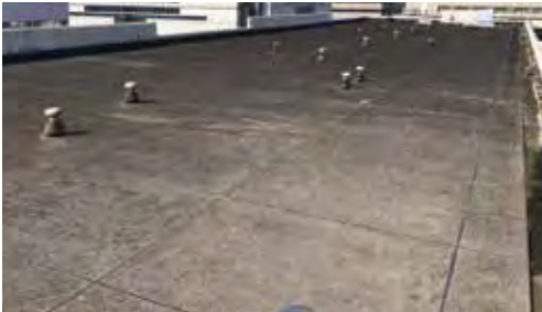
防水層保護コンクリート（既存）
