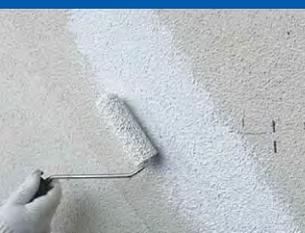
あらたにA-NCコートをつけずに、砂骨ローラーで端部を調整し馴染ませる。
