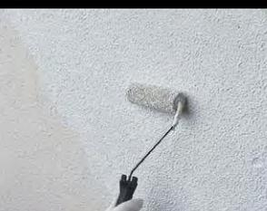
あらたに材料をつけずに、砂骨ローラーでA-NCコート上も含めパターンをつなげていく。主材を複層施工する場合には2層目主材も含め馴染ませるよう施工する。
