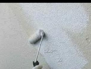
外壁面に対し、必要に応じ各種シーラーを施工後、A-NCコート直上をよけ、周囲を薄く被せながら主材(微弾性フィラー、複層塗材、外壁用塗膜防水材など)を施工する(配り塗り)。
