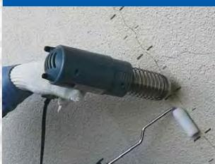
ヒーティングガンで熱を加え、テープを柔軟にした状態で、既存凹凸パターンに馴染むようローラー等で密着させる。
