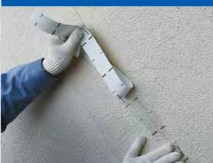
プライマーの乾燥後、ひび割れがテープ内に納まるよう、剥離紙を剥がしながら貼る。
