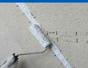
砂骨ローラーを用い、テープ上からプライマー塗布範囲にかけて塗布する(外側に向かい塗布量を徐々に少なくする)。
