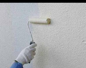
上塗材を必要回数塗布して施工完了。
