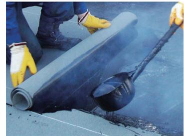
溶融したアスファルトを用いた防水の施工
