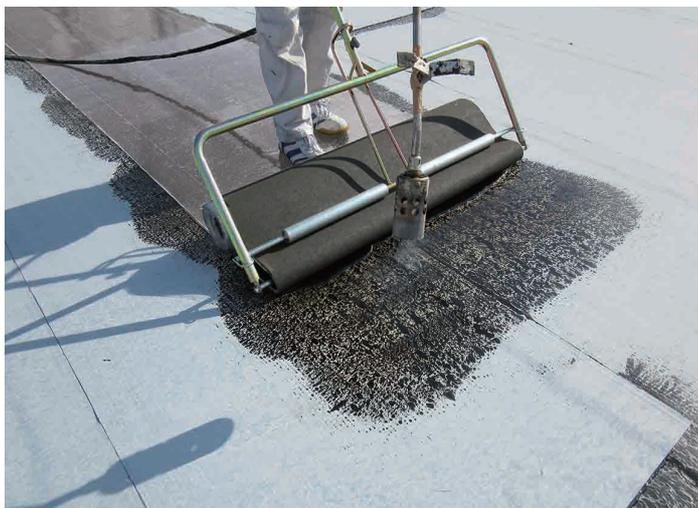
1. 溶融釜を用いずに、熱工法と同等の水密性を得られます。
