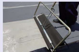
アスレイヤローラーを用いた施工の様子
