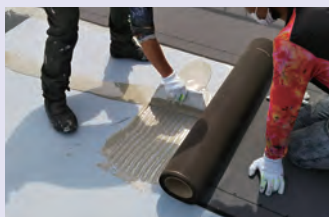
ゴムクシパケCを用いた施工の様子
