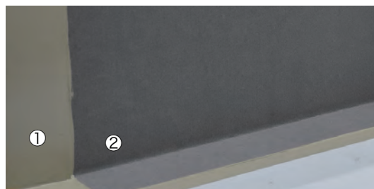
⑦... ②レイヤベスト (①レイヤコートC 立上り用塗布 1.2~1.3kg/m 2 )
