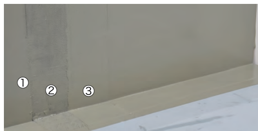
④... ①レイヤコートC立上り用1.2~1.3kg/m 2 +②マットFCII+③レイヤコートC立上り用1.2~1.3kg/m 2
