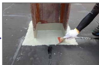
改質アスファルト系塗膜防水 補強布複合法 アスレイヤCの施工
