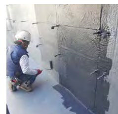
側部:UGプライマー塗布
