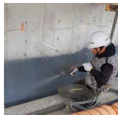
側部:オルタックスプレー施工
