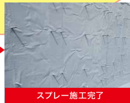
後打ちコンクリート接続用 UGプライマー塗布 ⇒躯体コンクリート打設へ
