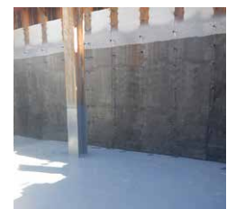
側部:施工完了
