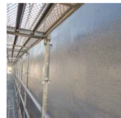
側部:施工完了
