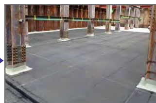
中間杭部の改質アスファルト系 塗膜防水併用処理 [完了]
