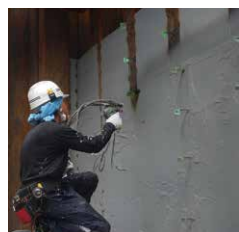
側部:オルタックスプレー施工
