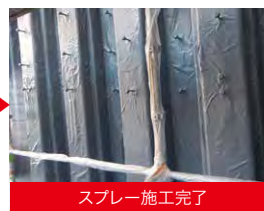
後打ちコンクリート接続用 UGプライマー塗布 ⇒躯体コンクリート打設へ
