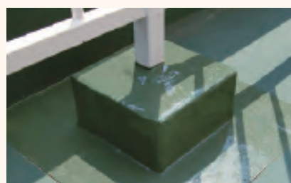
GO-JIN併用の架台施工
