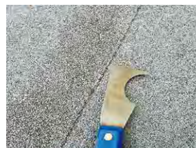
施工翌日の接合部
