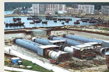
1977年香港の地下鉄沈埋管工事に採用
