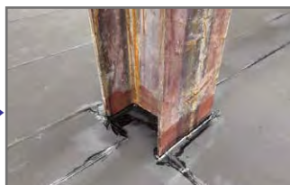
底部ゴムロンフォルトM (改質アスファルトシート)貼り込み
