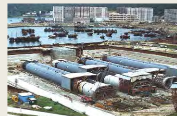
1977年香港の地下鉄沈埋管工事に採用
