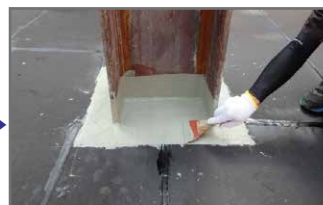
改質アスファルト系塗膜防水 補強布複合法 アスレイヤCの施工
