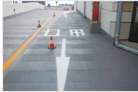
スロープ施工後(ストライプ仕上げ)
