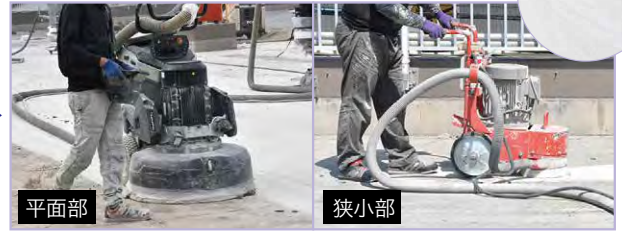
下地処理(研磨作業)
