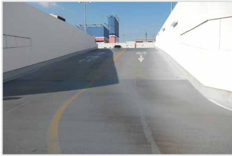
スロープ施工前
