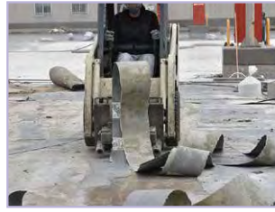
既存防水撤去
