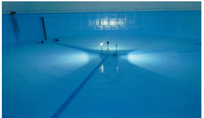
上水施設(配水池)
