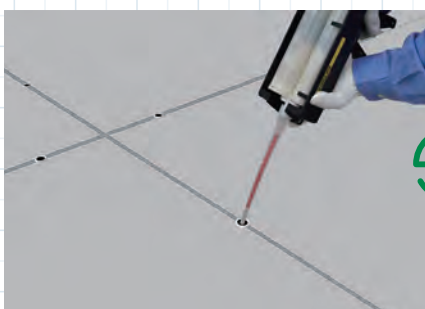
エポキシ樹脂注入
