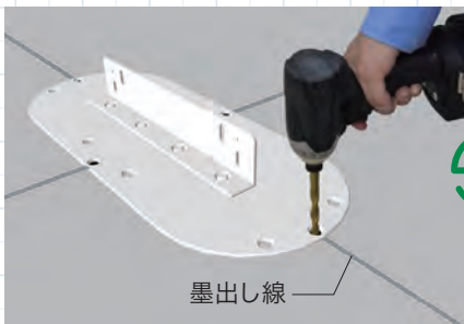
防水施工終了後コンクリート部本穴開け (ドリル径: 10.5mm)
