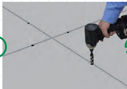
断熱材座掘り・穴あけ (ドリル径: 16mm)
