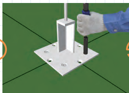
ソーラーステイ アンカー固定
