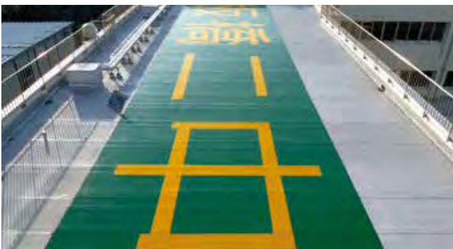
板橋区立板橋第二中学校 露出アスファルト防水の上に下貼りシート施工+フレクターフィルム(イエロー)
