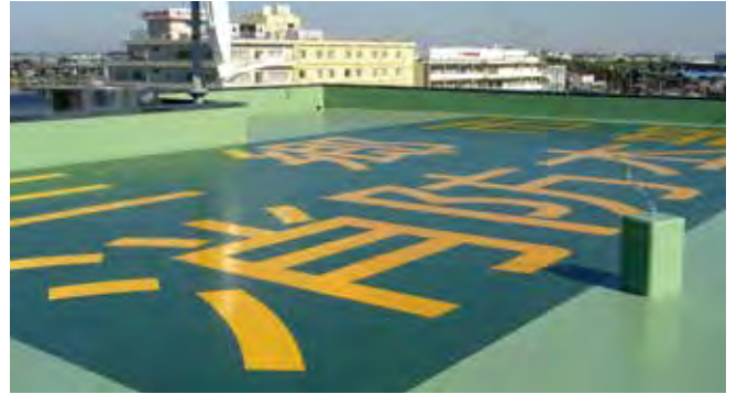
三郷市消防本部 既存ウレタン防水の上に下地処理 +フレクターフィルム(イエロー)
