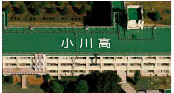
埼玉県立小川高校 ビュートップ防水の上にフレクターフィルム(ホワイト)
