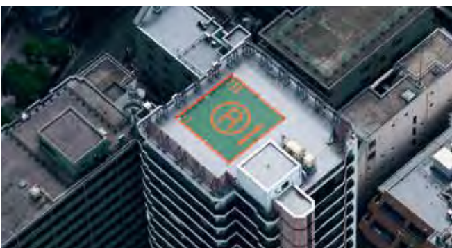
クリオスカイタワー 篠崎 オルタック防水の上にフレクターフィルム(オレンジ)
