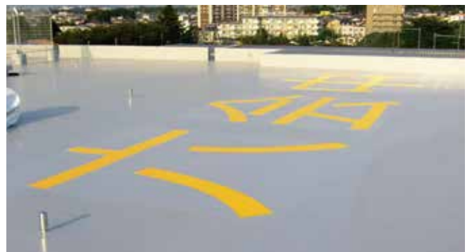
藤沢市立六会中学校 オルタック防水の上にフレクターフィルム(イエロー)
