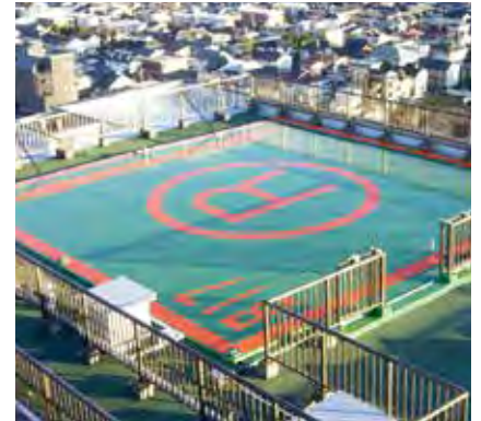
オルタック防水の上にフレクターフィルム(オレンジ)
