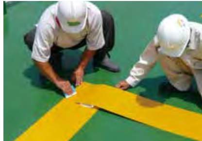
貼り付け工程1
