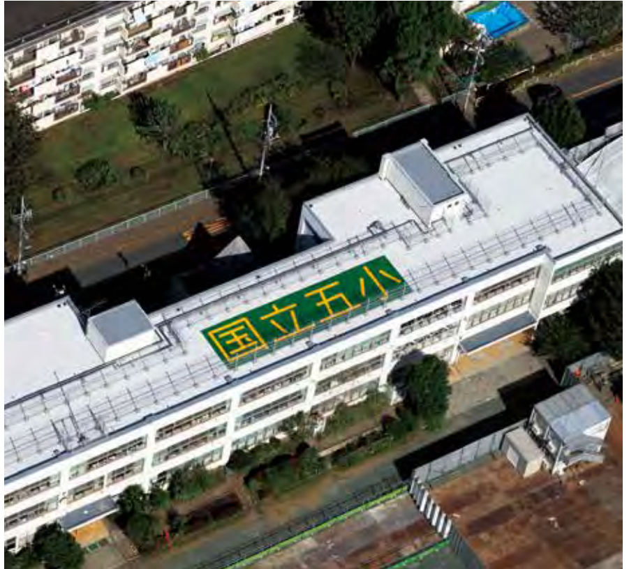
オルタック防水の上にフレクターフィルム(イエロー)
