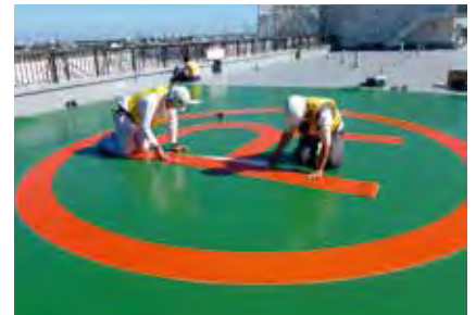
貼り付け工程2(緊急救助用スペース)
