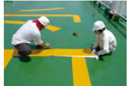
貼り付け工程2
