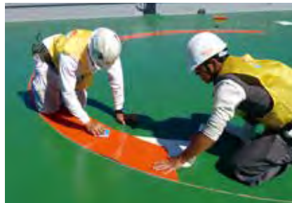
貼り付け工程1(緊急救助用スペース)
