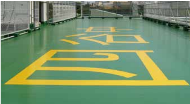
新宿区立四谷中学校 オルタック防水の上にフレクターフィルム(イエロー)
