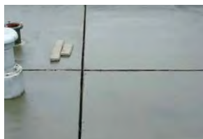
既存目地材の撤去 リグレー・ネオで下地処理
