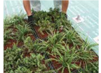
水下側よりGCユニット敷設
