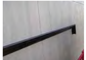
ツルパワーガード本体の取付け
