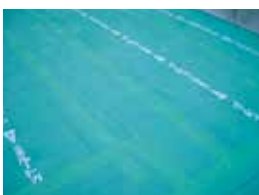
ルートガードD貼付け
