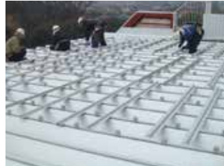
SRG下レール仮置き
