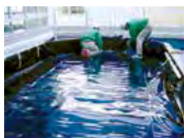
FDフィルム敷設
