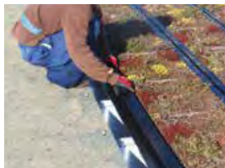
SRG見切金物を、押え金具およびSRG下レールへ固定する。
