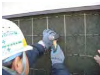
FDKワッシャーを付けた状態で下穴を開け、アンカーを打込む。
