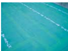
ルートガードD貼付け
