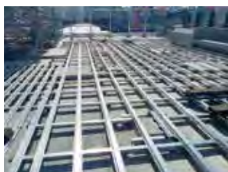
下地組み完成。
