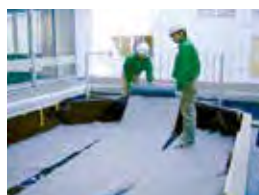
FDマット敷設
