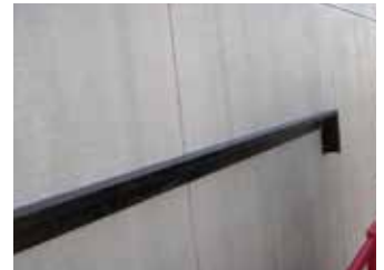
ツルパワーガード本体の取付け
