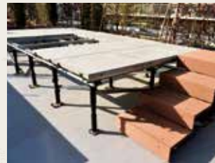
二重床の構造展示 ・ウッドデッキ階段 ・PCパネル
