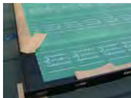
FDウォール取付け
