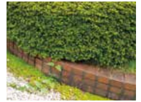
レンガ積み施工例
