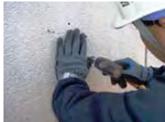
アンカー打込み
