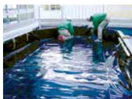
FDフィルム敷設
