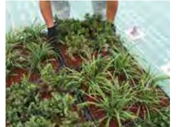
水下側よりGCユニット敷設
