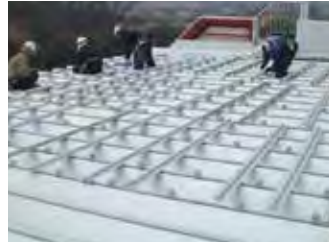
SRG下レール仮置き
