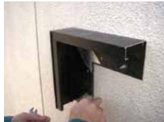
ツルパワーガードコーナー部の取付け
