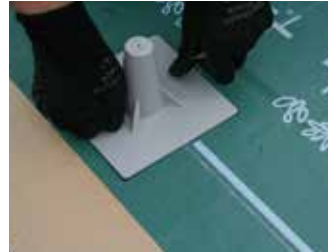
FDコーンH86取付け
