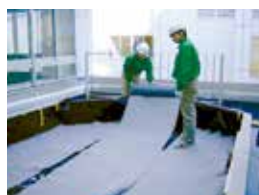
FDマット敷設
