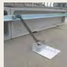
転倒防止用補強 プレート設置例
