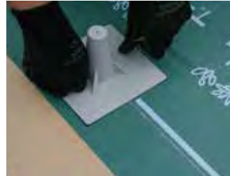
FDコーンH86取付け
