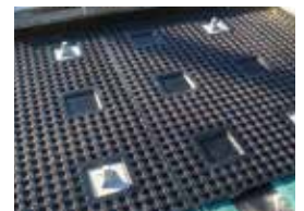
FDコーン貼付け
