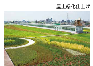
屋上緑化仕上げ
