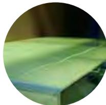
機械的固定工法では、防水層が浮き上がり、波打ち(フラットリング現象)が発生しているのが、レーザーラインで確認できる。
