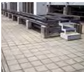
既存タイル下地
