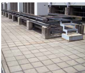
既存タイル下地
