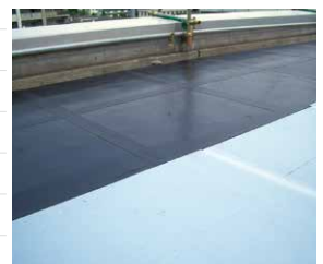
オルタックシート貼り
