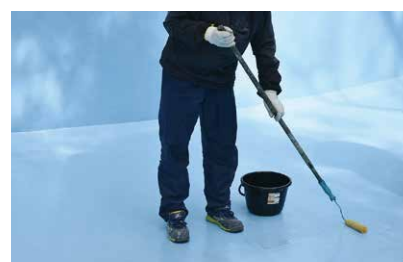
UAコートクリア塗布作業
