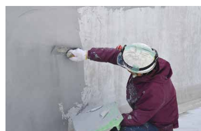
左官ゴテによるUAベースE塗布作業
