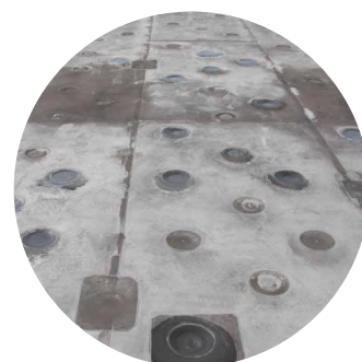
強風によるフラッターリングを抑制するためディスクを多量に打ち込んだ屋根
