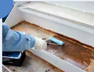
踏み面モルタルを撤去の上
