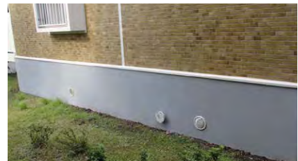
透湿+撥水保護塗料 RVC-B1 (リバンプコート) ※RV/ハッスイコート ※入った水分を透過させながら表面では撥水させる 特に雨がかり部に有効
