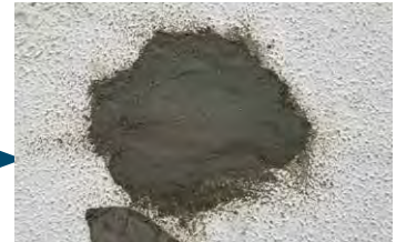
埋戻し▶RVモルタル断面
