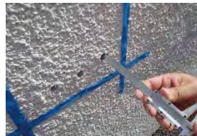
削孔深さの測定
