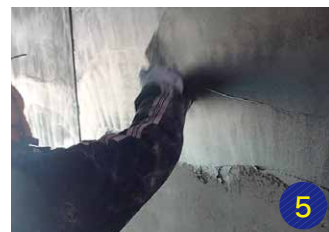
セメント材（RVペースト / RVモルタル）の塗布
