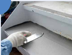
モルタル表面に対し
