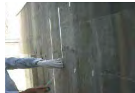
鉄筋位置マーキング
