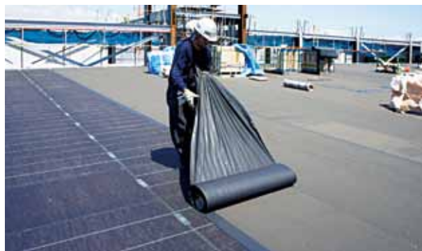
7. アスファルト防水(ストライプRF工法)の施工
