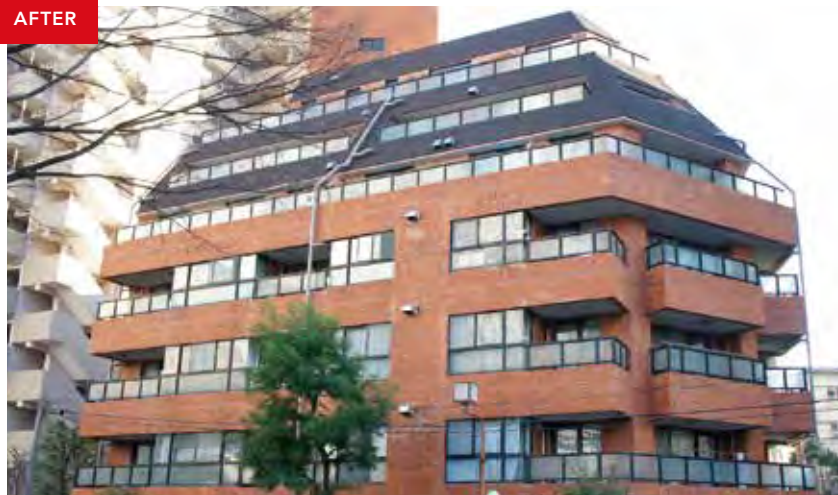
実際にシングルにて改修工事を施工した建物(SA-310)
