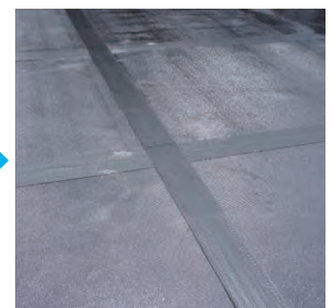
下地処理完了
