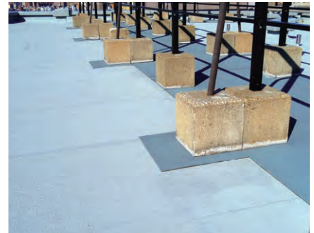
保護材にバリキャップを用いた架台設置例
