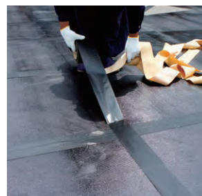
保護フィルム撤去後、目地部にバリテープC貼付け
