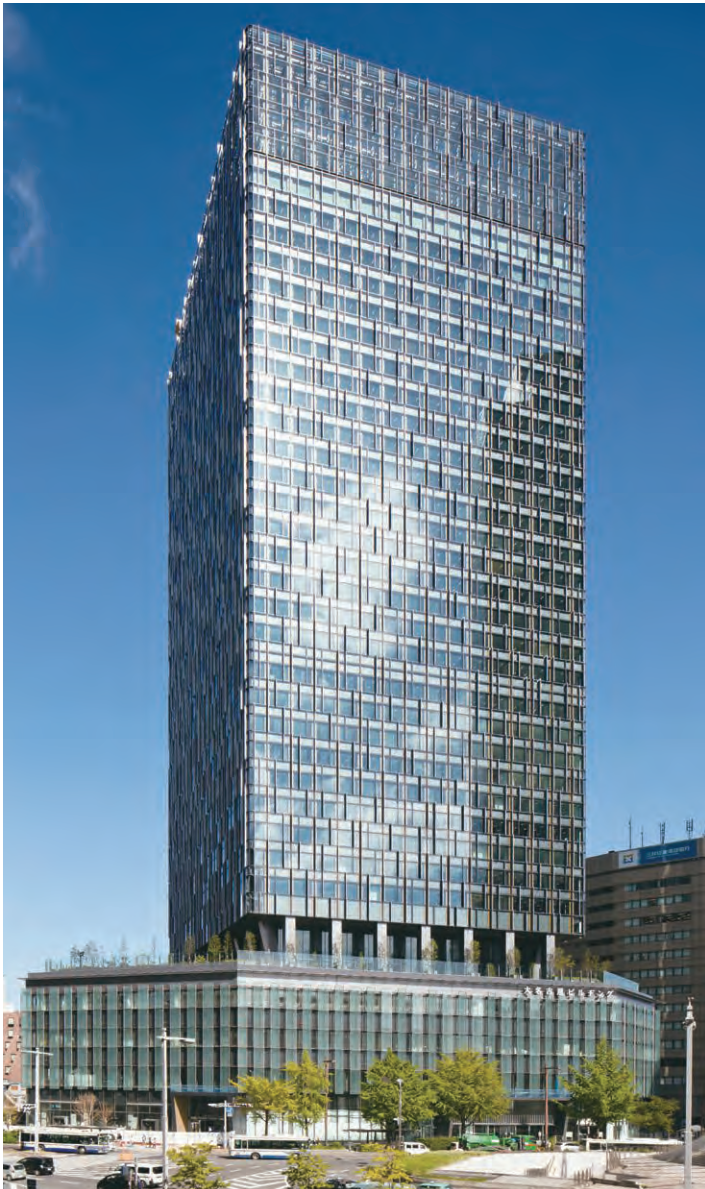
大名古屋ビルヂング
