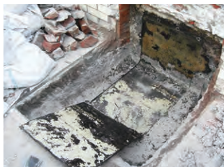
防水層切取り
