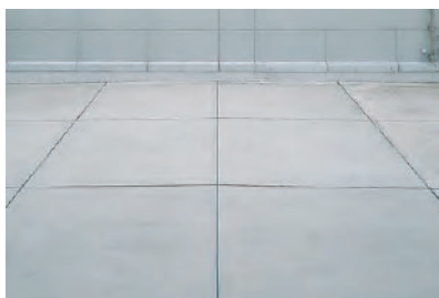
《保護コンクリート仕上げ》
