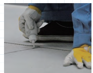
溶着後Uシール処理
