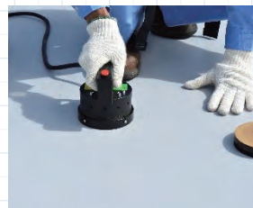
VTヒーターでビュートップシートをプレートへ融着
