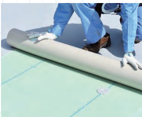
ビュートップシートを敷設
