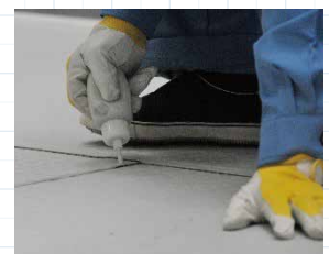
溶着後Uシール処理
