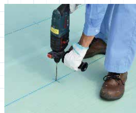
ドリルで下穴開け
