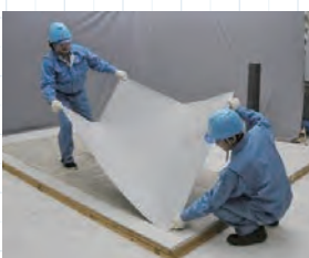
位置を合わせビュートップシートを下地に貼り付ける
