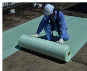
Uマット200を敷設
