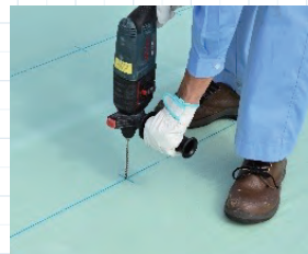
ドリルで下穴開け
