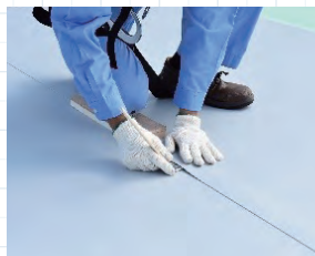
シートジョイント部を溶着剤を塗布し、専用の押え板で圧着
