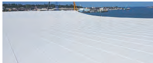
VTリブラインを使用した屋根の仕上がりイメージ
