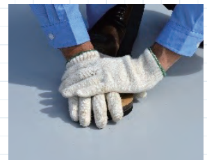
融着後、専用押え板で圧着
