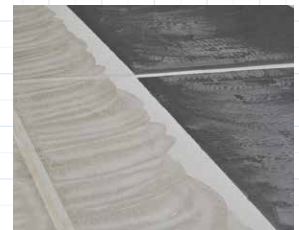
下地、シート裏面両方に接着剤が塗布されていることを確認
