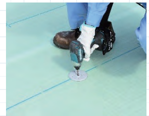
下穴にディスクの穴を合わせ、アンカーを打ち込み、固定
