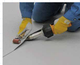
シートラップ部を熱風溶接機を使用し、ゴムローラーで転圧、圧着
