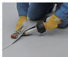
シートラップ部を熱風溶接機を使用し、ゴムローラーで転圧、圧着
