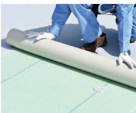
ビュートップシートを敷設
