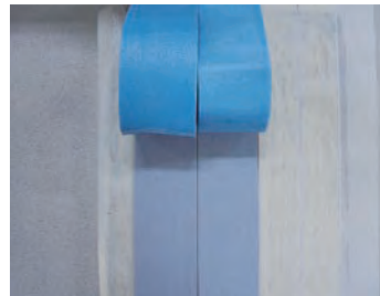
OTプライマー-A※/ ビュートップシート界面剥離
