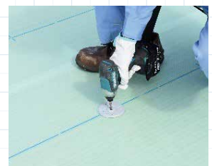
下穴にディスクの穴を合わせ、アンカーを打ち込み、固定
