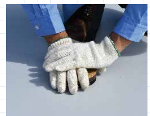
融着後、専用押え板で圧着
