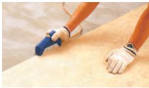
エッジトリマーで端部をカット
