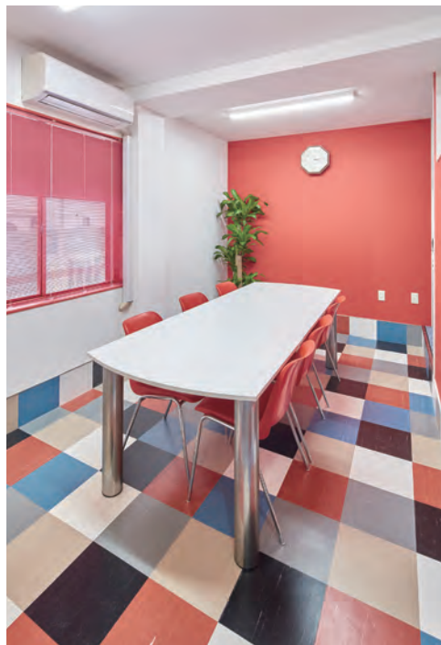
玄関側に設置された打ち合わせスペースには、明るいPタイルのパターンを採用。巾木は設置せず、Pタイルを壁にまで立ち上げた。
