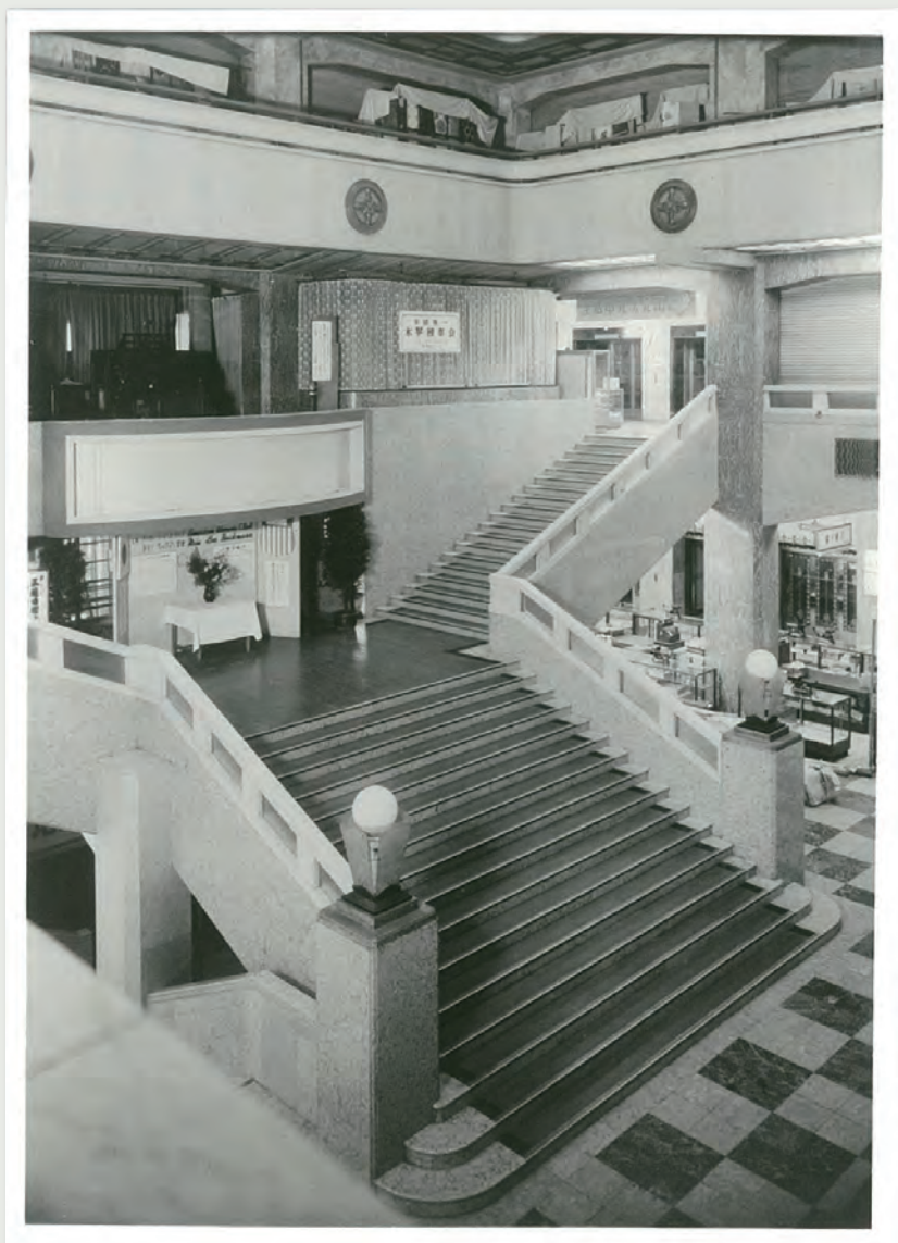
Pタイルの前身 アスファルトタイル 日本橋三越本店 中央ホール (1951年頃)
