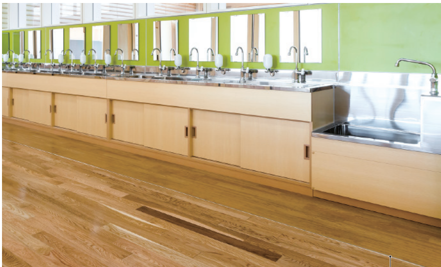
手洗い場廻りは、ビニル床シート「エコ・ディライトEM」。見切り材で廊下のフローリングと分けている
