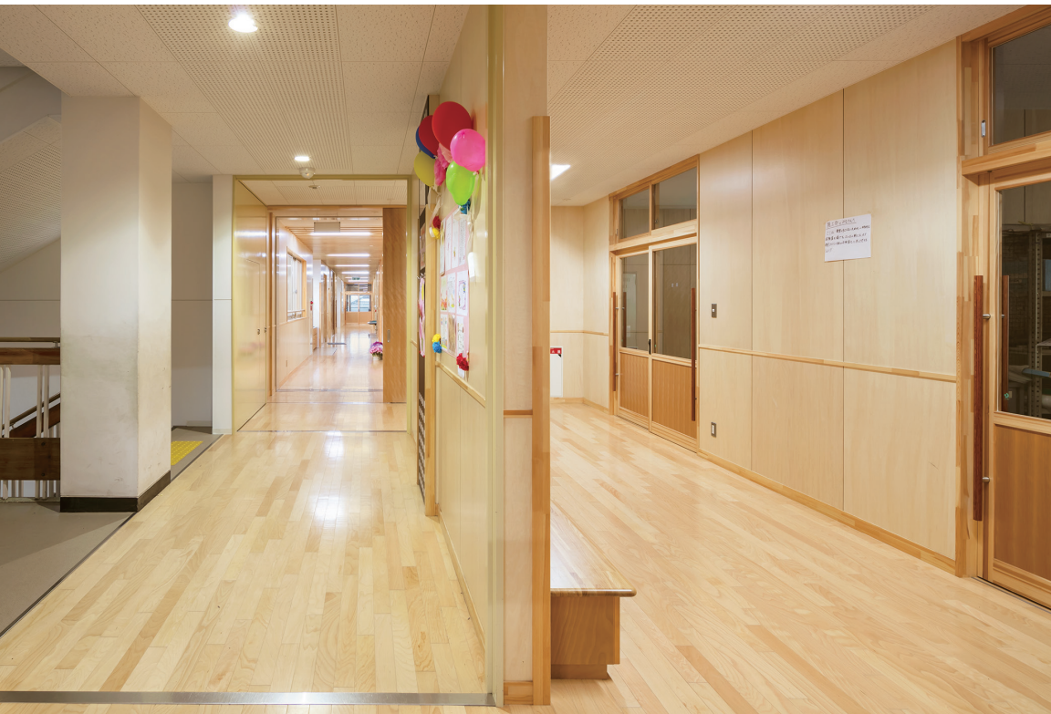
階段室の前にある教室の間仕切り壁を撤去し、木製の掲示壁面を設置し、その奥に小教室を設けた。
