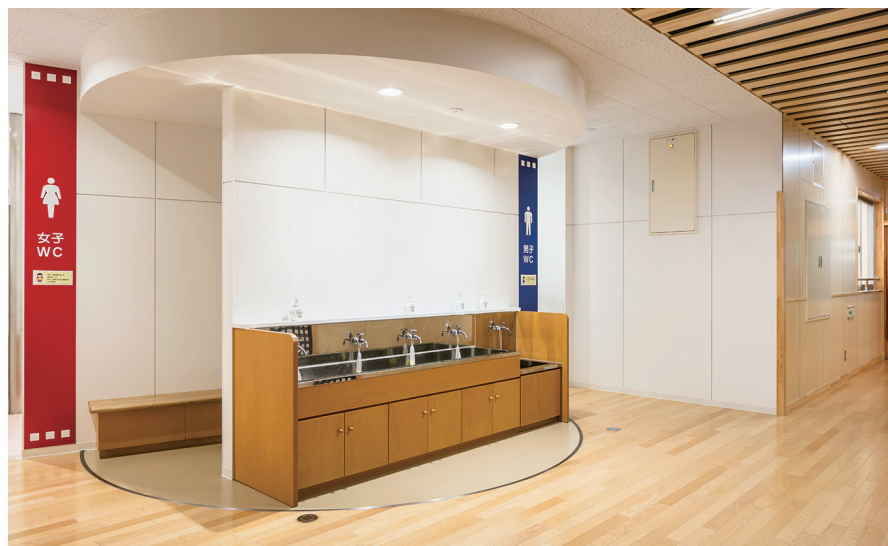
改修により明るく快適になったトイレ(上)。バリアフリーのトイレと流し(下)
