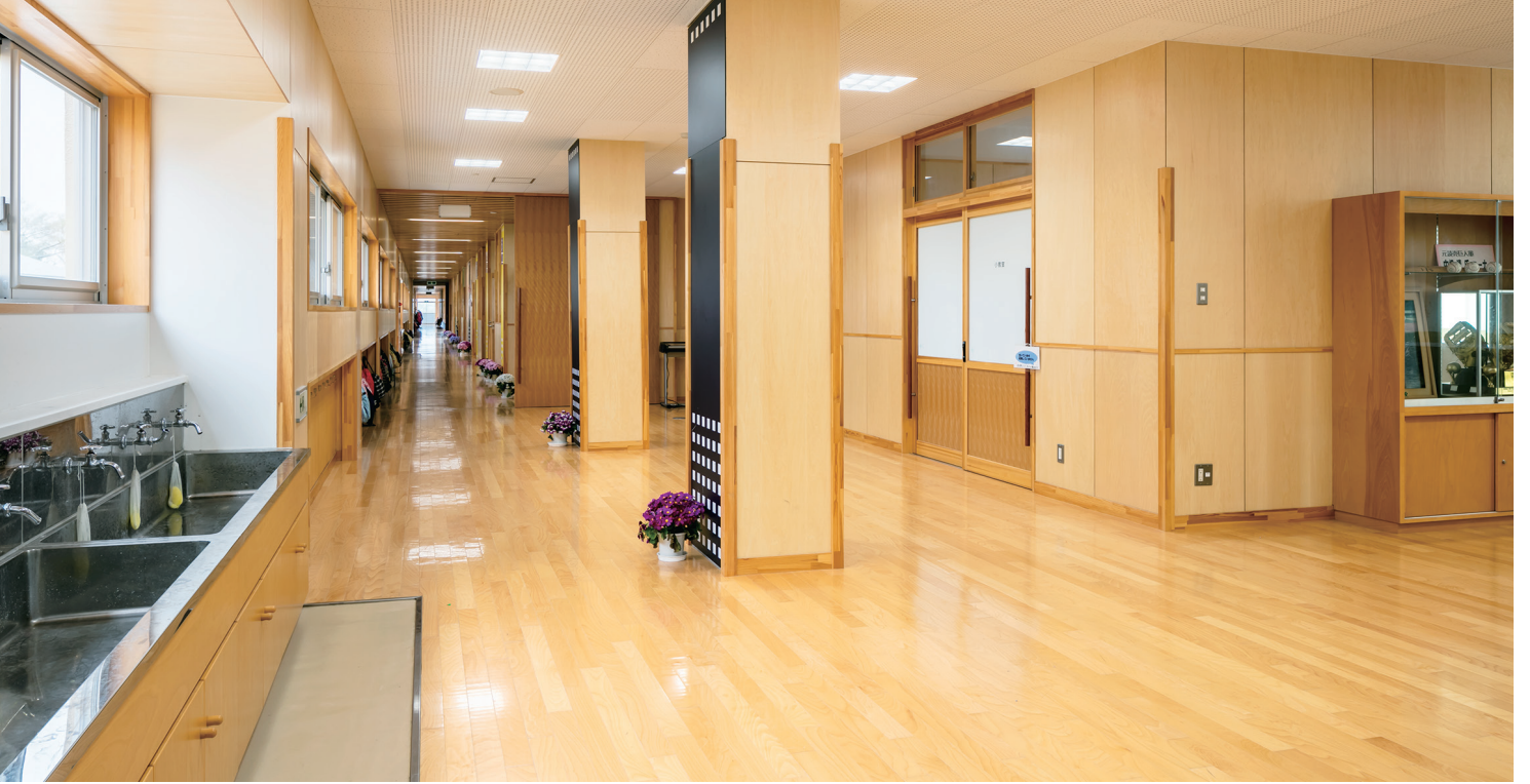
水回りにはビニル床シートをさりげなく配している。(廊下床 天然木、廊下床水回り ビニル床シート パーマリウム)
