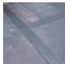
下地処理完了
