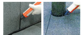
専用シール材によるラップ処理
