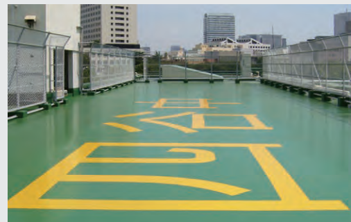
■ 屋上・庇 屋上改修は、外断熱、ヘリサイン、緑化、太陽光発電など、広い屋上を有効活用するチャンスです。
