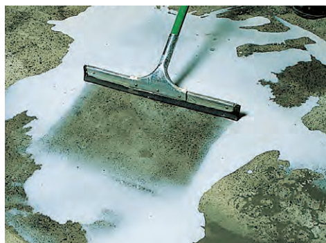
スクイージーやローラーバケで下地全面に塗布する。
