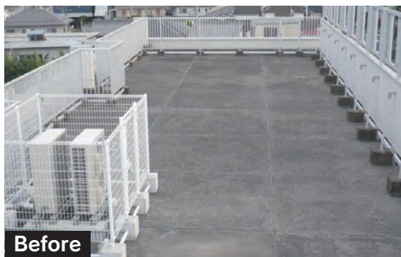
Before 経年劣化した屋上の押えコンクリート。
