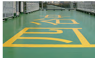
オルタック防水の上にフレクターフィルム (イエロー)
