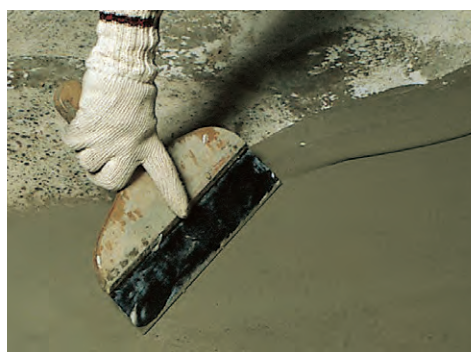
地べらで全面に塗布する。
