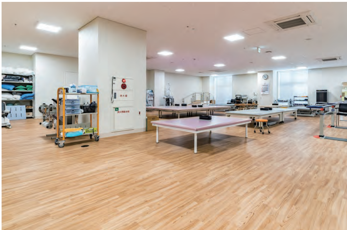
発泡層のあるビニル床シートは、 衝撃吸収性があり転倒の際も衝撃をやわらげます。 丹波医療センター(兵庫県)
