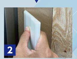
防水テープをサッシフィンの入角線に 押し込むように圧着します。
