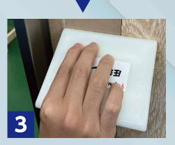
防水テープを外壁面材に圧着します。
