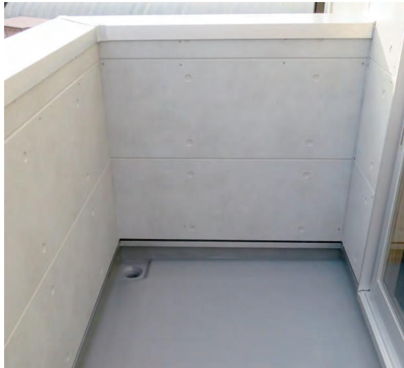
パティオールは、スチレン等特定化学物質を使用していないウレタン塗膜防水材と、通気緩衝シートを組合せた複合型の防水システムです。新築・改修ともに使用出来ますが、周辺環境の配慮に優れている為、特に改修工事に向いています。
