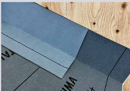
屋根と壁との取り合い部
