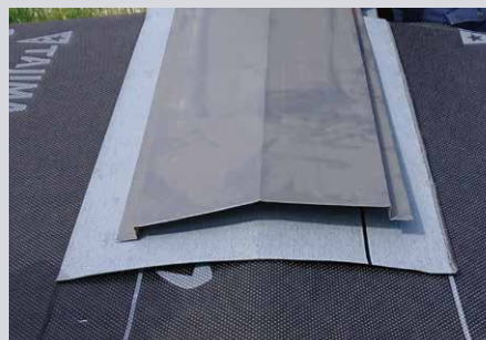
棟部増し張り
