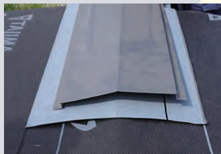
棟部増し張り
